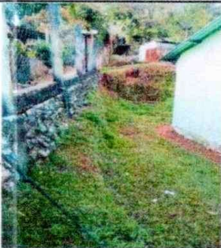
Foto 3: AQUÍ SE VE EL LADO IZQUIERDO A LEVANTAR MURO DEL MODULO 1 L=31.8 M (MAMPOSTERIA DE BLOCK)
