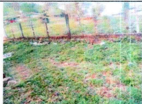
Foto 4: EN EL LADO DERECHO SE OBSERVA EL LUGAR A INTERVENIR DEL MODULO 2 L=25 M (MAMPOSTERIA DE BLOCK)
